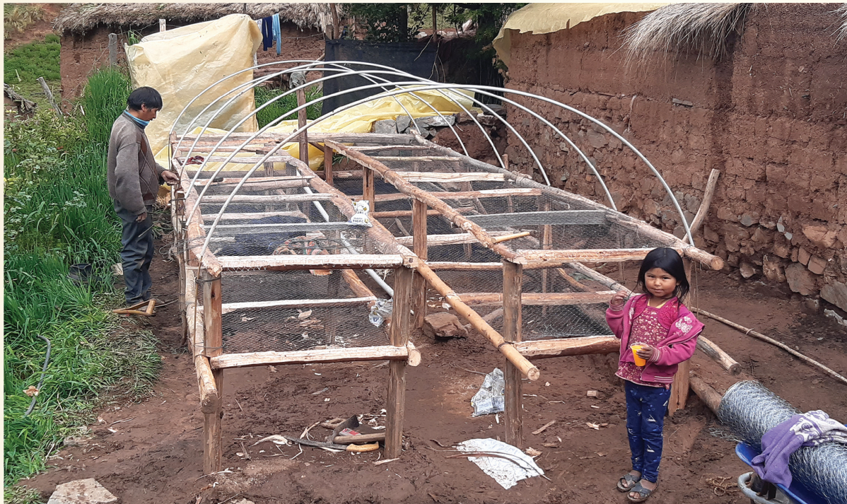
FOTO 8: Armado de la cubierta, en forma de semitunel
