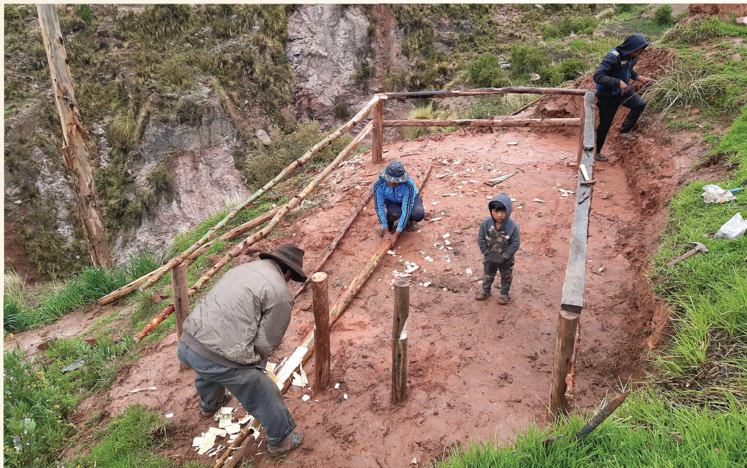
FOTO 2: Selección del lugar y nivelado del piso
