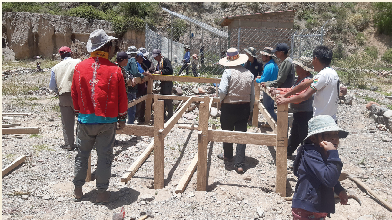
FOTO 5: Armado de la bandeja del 2do piso y el pasillo interno
