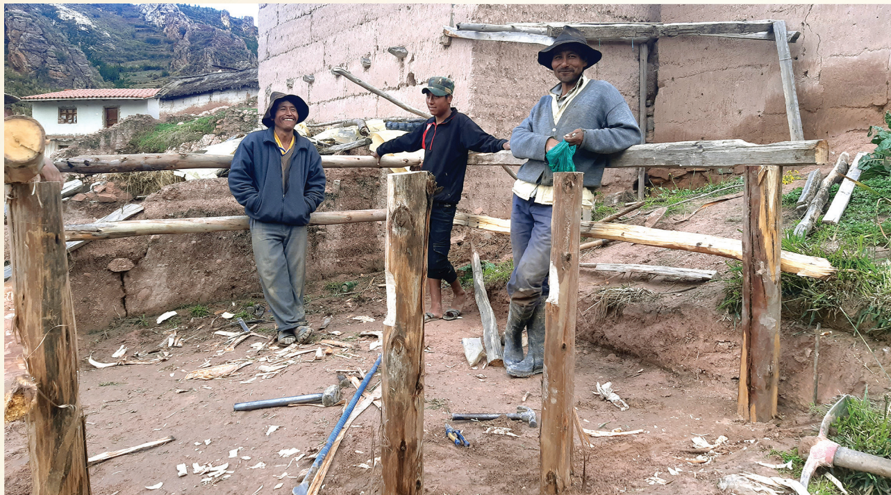
FOTO 4: Armado de la estructura del secador solar
