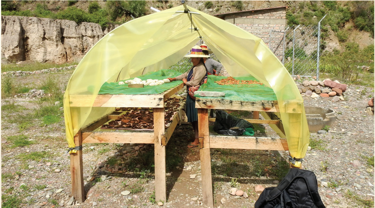
FOTO 9: Armado de la cubierta de proteccion y colocado de la malla milimetrica
