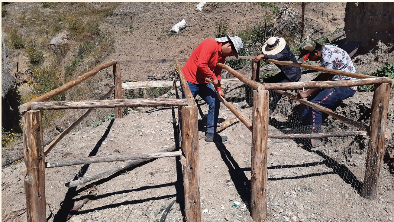
FOTO 6: Armado de las bandejas y pasillo
