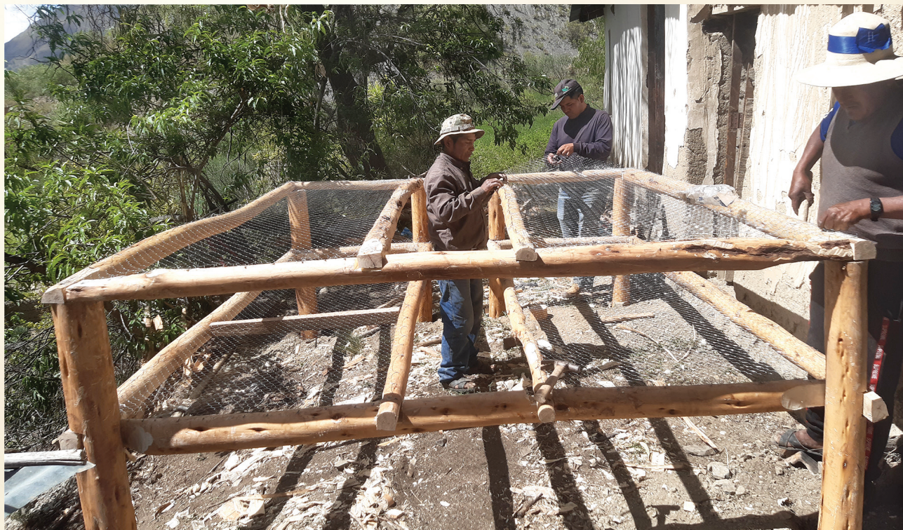
FOTO 7: Colocado de la malla gallinera en las bandejas
