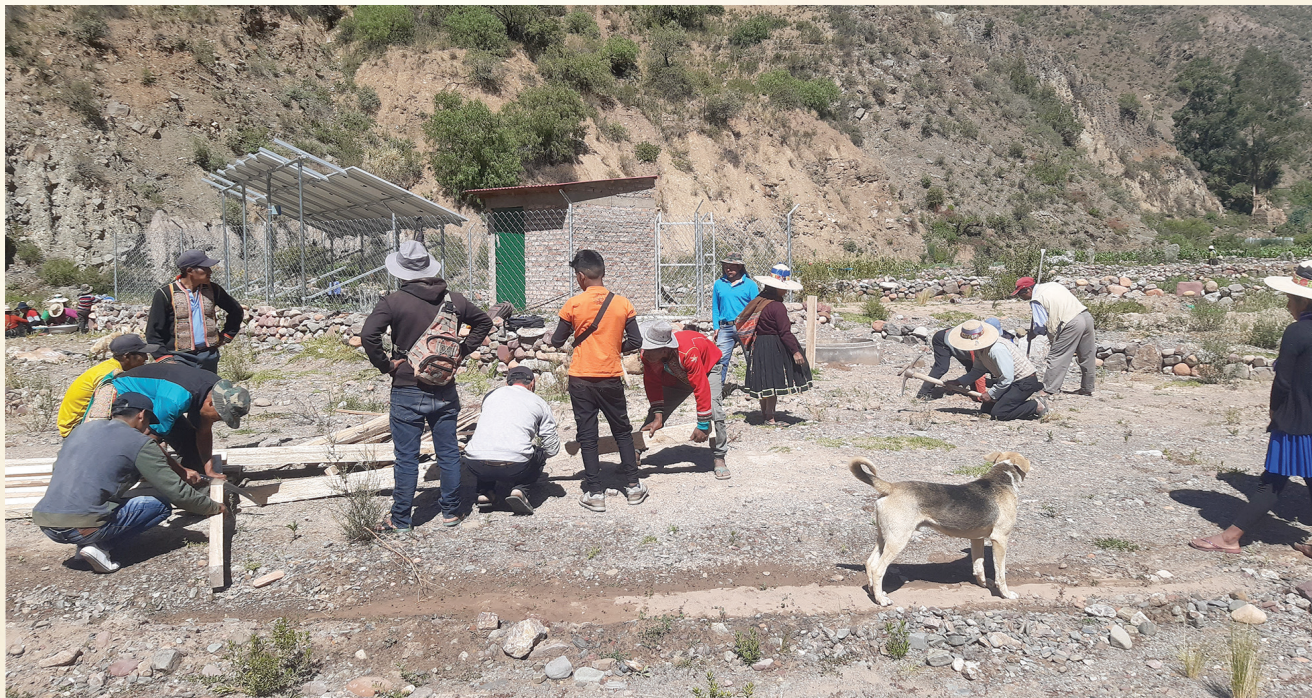
FOTO 3: Preparacion de las o bolillos y calado de los postes y travesaños
