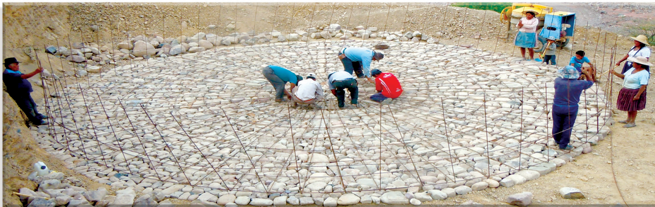
FOTO 5: Soladura o empedrado y armado del canastillo
