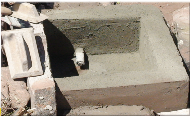
FOTO 2: Cámara desarenadora
