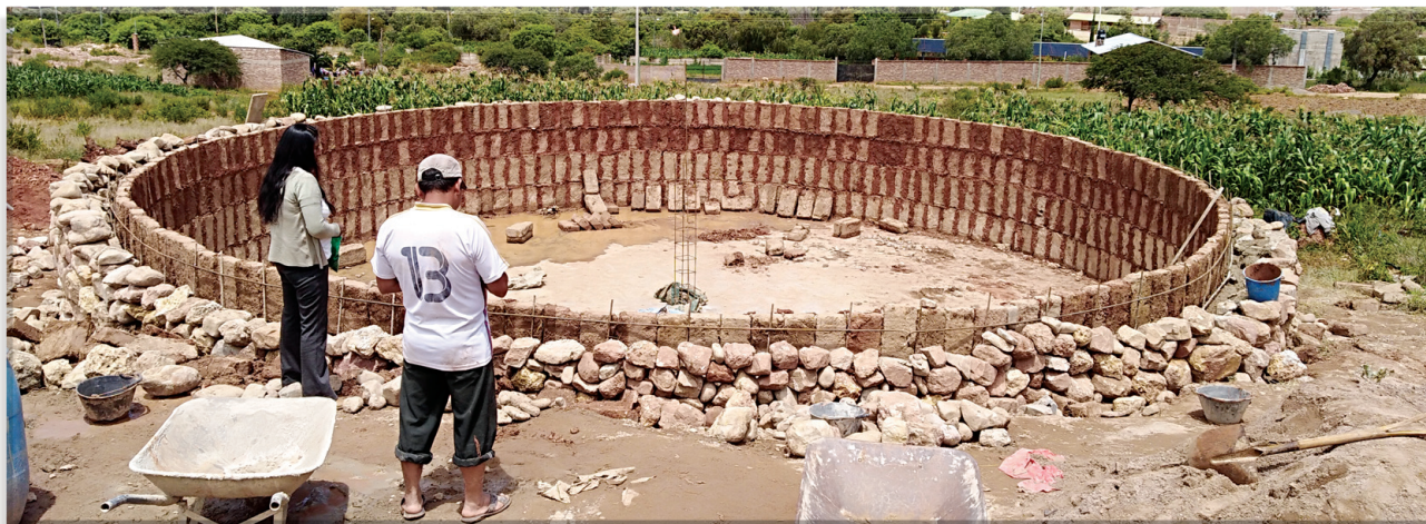
FOTO 7: Armado del molde interno con adobes y molde externo con piedra
