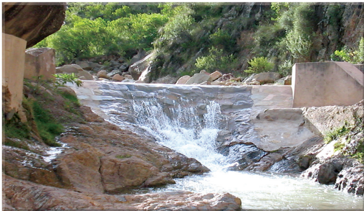
FOTO 1: Obra de tioma en lecho de río
