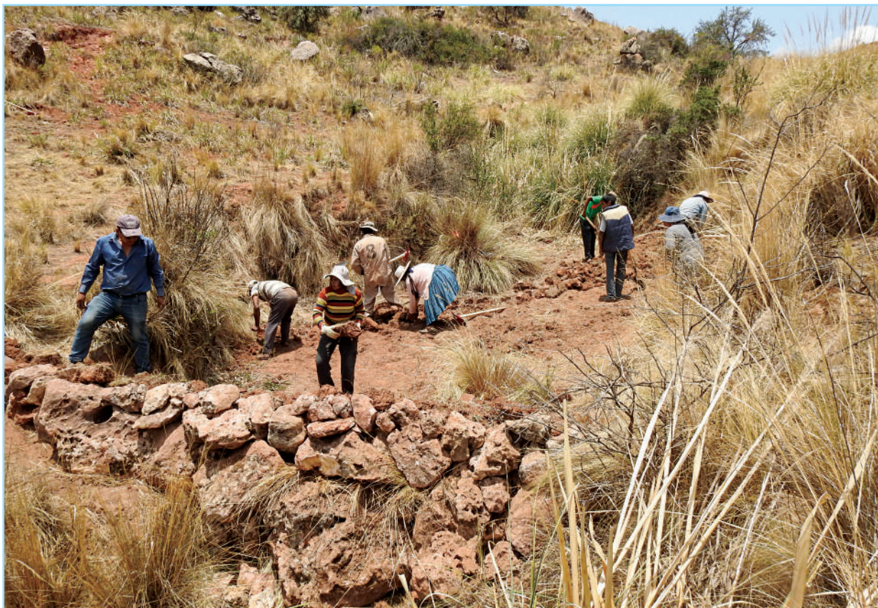
FOTO 8: Construcción manual de lagunas artificiales con fines de infiltración
