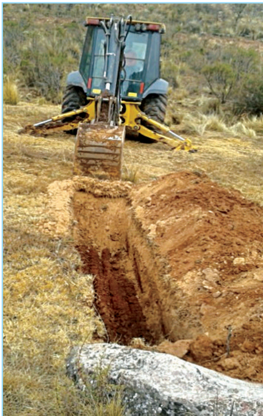
FOTO 6: Excavacion de zanjas con maquinaria
