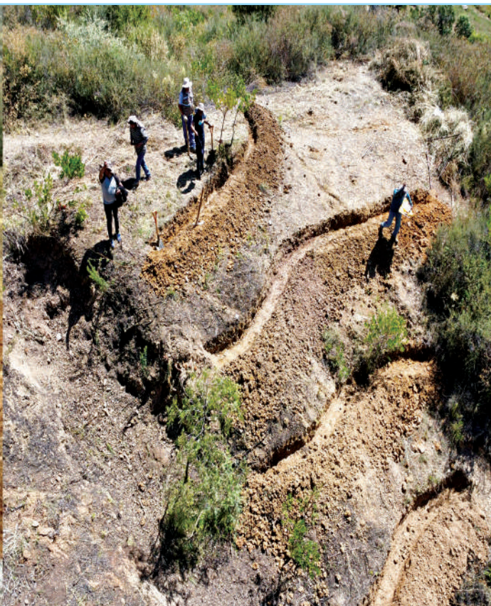
Foto 7: Excavacion de zanjas de forma manual
